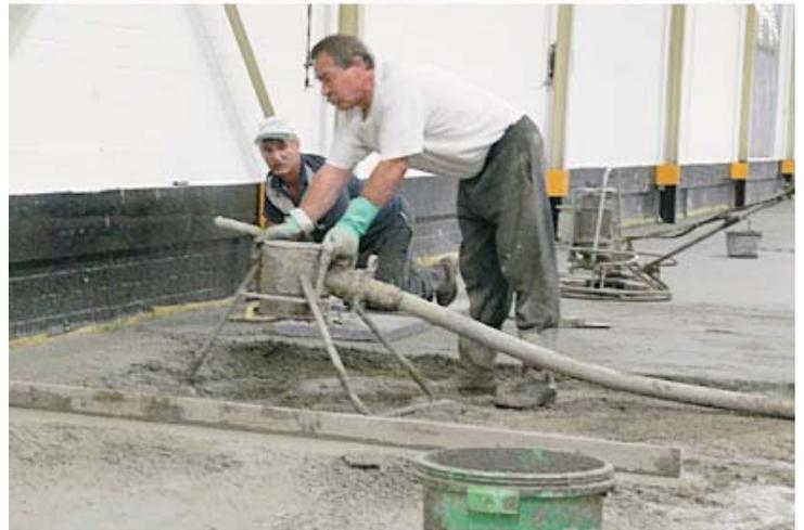
Durch jahrelange Fahrbeanspruchung sind die Hauptfahrwege in einer Produktionshalle bei VW stark abgenutzt und beschädigt. Die Untersuchung der Fußbodenkonstruktion durch Bohrkernentnahmen ergab, dass die vorhandene „Sandwichkonstruktion“ aus unterschiedlichsten Estrichen nicht überarbeitet werden konnte.
