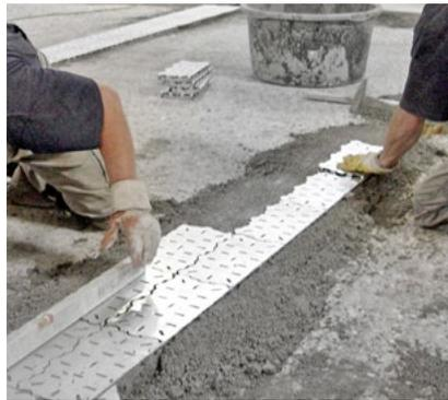
Verlegemörtel für Stahlankerplatten
