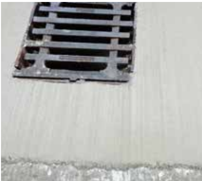
Reparaturen im Außenbereich
