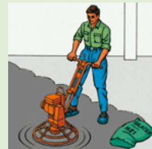
Maschnielles einarbeiten durch rotierendes Glätten
