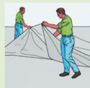
Nach Einbau mit PE-Folie abdecken
