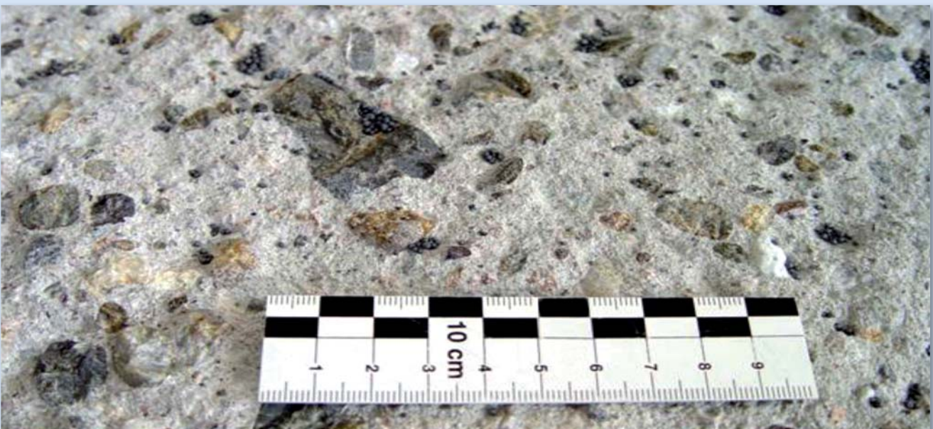
Fräs-/Strahlbild optimal: freigelegtes Korngefüge mit sichtbarem Kornbruch
