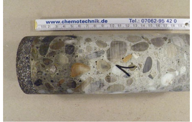
Stark verölter Beton unter Magnesiaestrich
