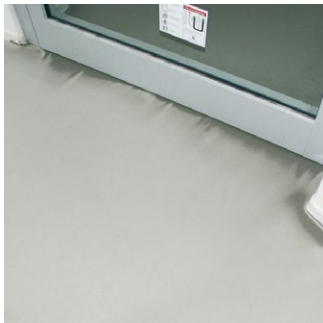
Farbänderung durch Zugluft
