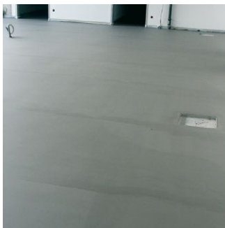
Glanzgradunterschiede in der Versiegelung
