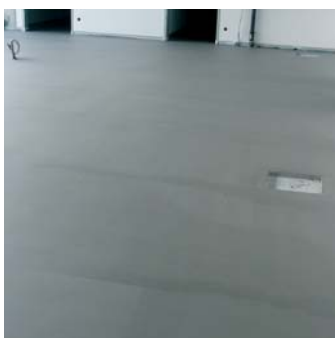
Glanzgradunterschiede in der Versiegelung
