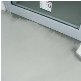
Farbänderung durch Zugluft
