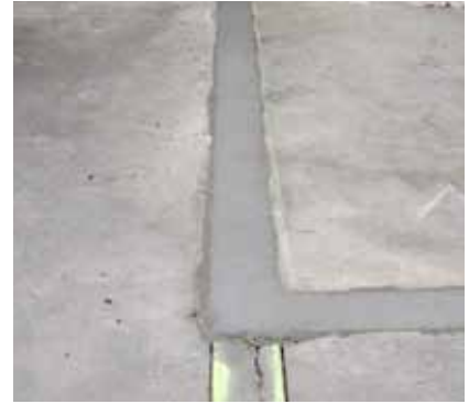
Reparaturen im Innenbereich
