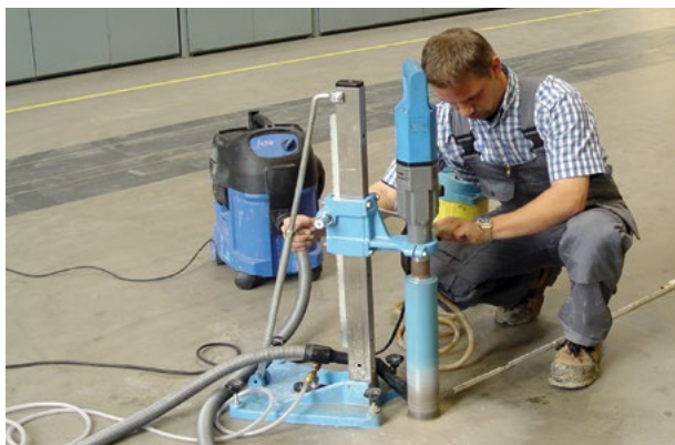
Bohrkernentnahme
