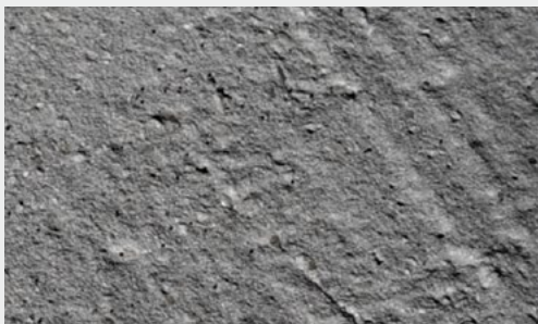
Fräs-/Strahlbild ungeeignet: Reste von Zementschalen
