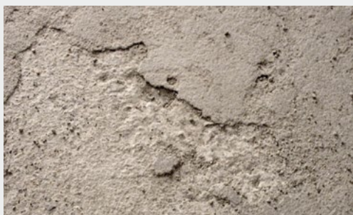
Untergrund ungeeignet: Ablösbare Mörtelschichten abtragen
