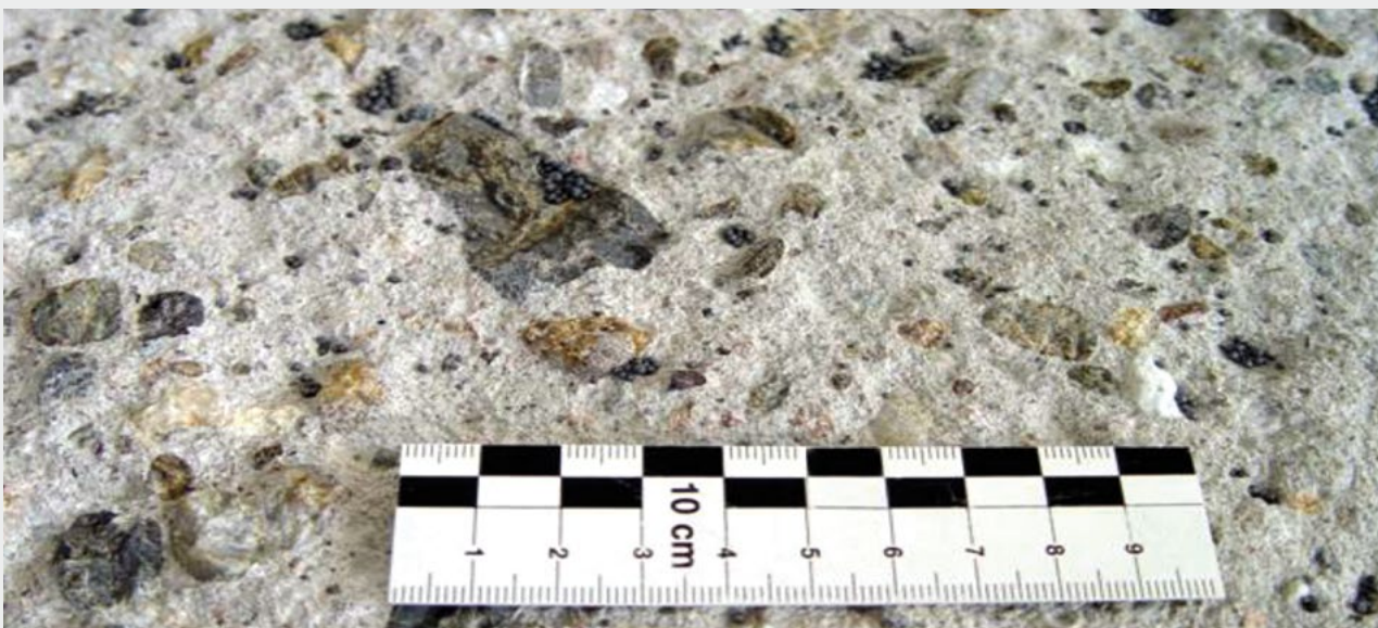
Fräs-/Strahlbild optimal: freigelegtes Korngefüge mit sichtbarem Kornbruch, Oberfläche rau und griffig
